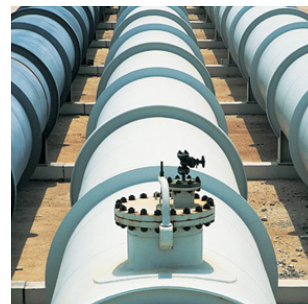
Proteção contra o ataque químico
