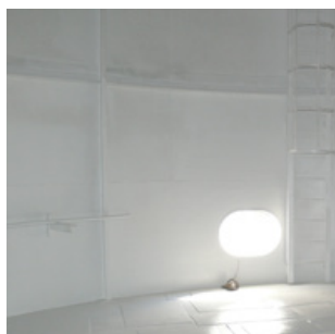
Tanques de armazenamento
