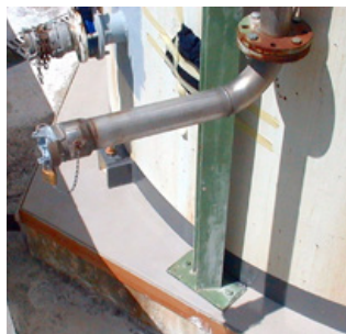
Étanchéité de surfaces
