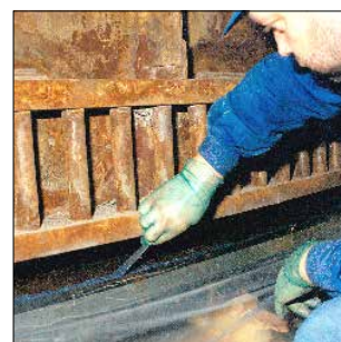
Tratamento cerâmico de um flange
