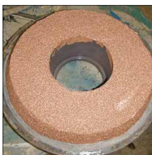
Reparação de uma câmara de um decantador
