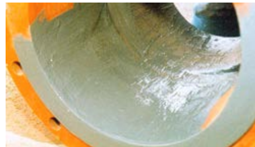
Reparação do dia a dia – quando é aplicada uma cerâmica epóxi com o pincel. Superfícies irregulares que nenhum técnico deseja ...
